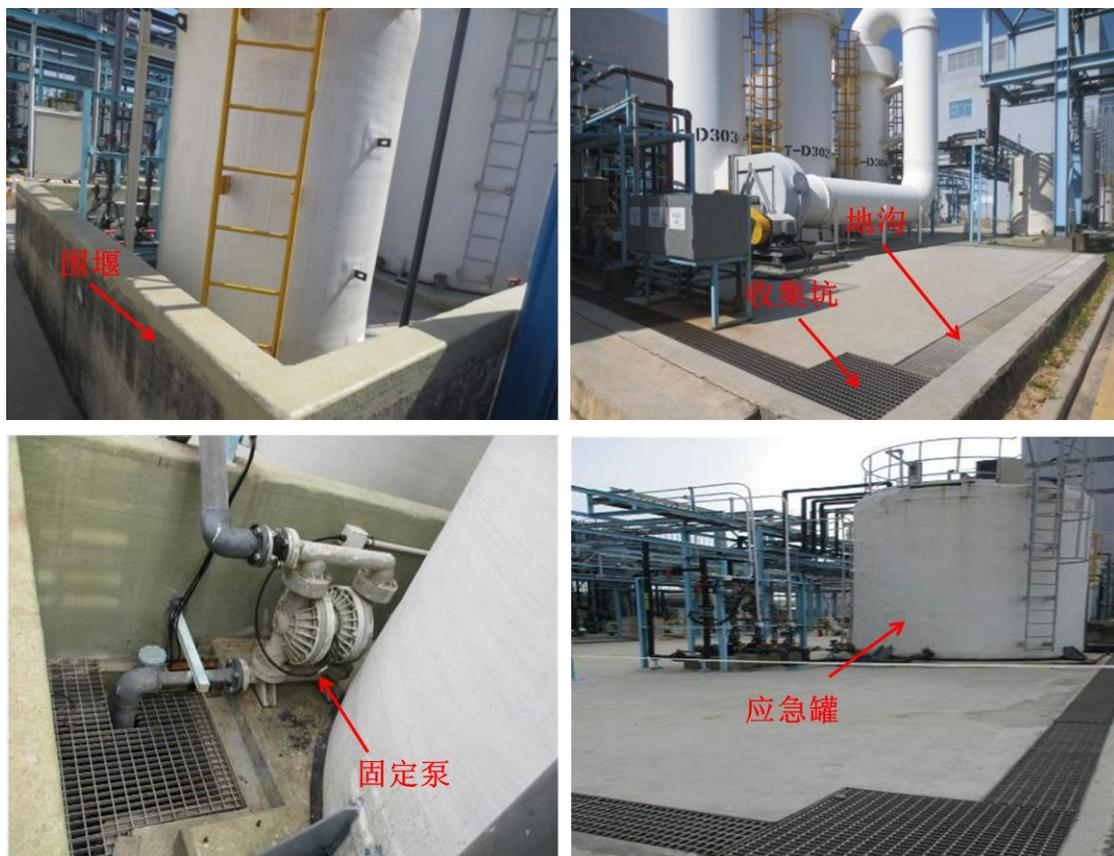
图 8-19 硫酸铵罐旁围堰、地沟和应急罐
