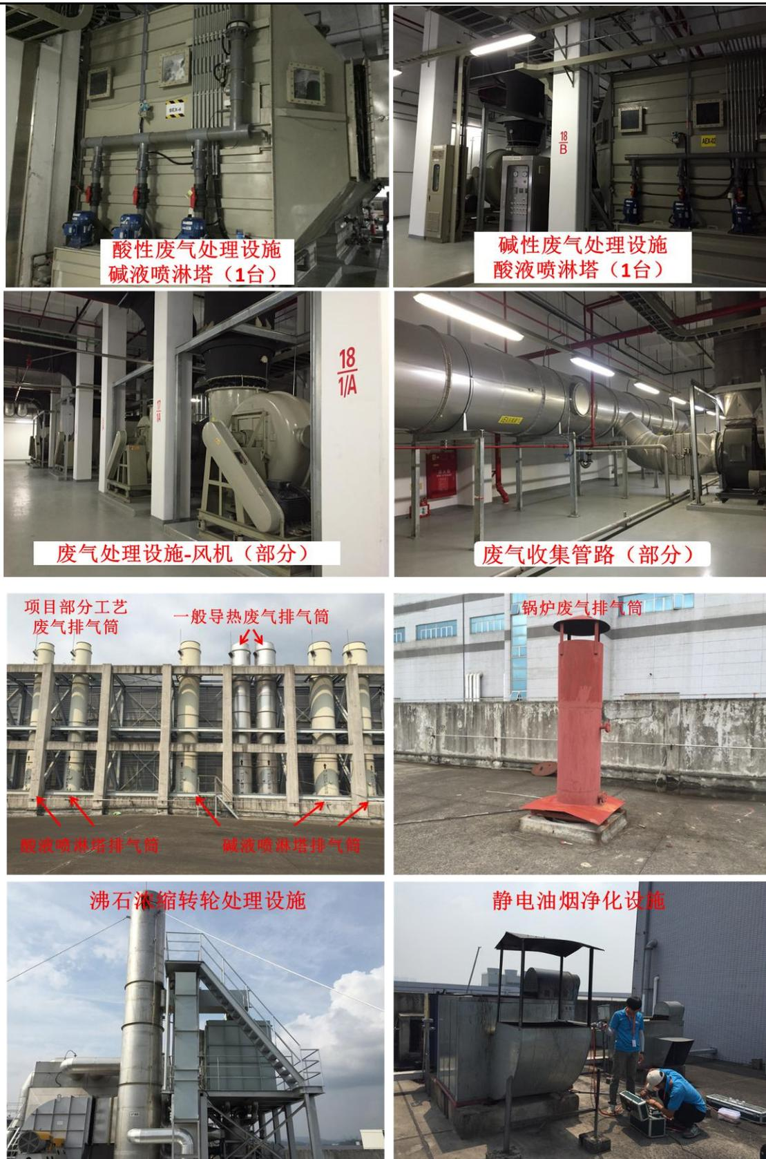
图 3-17 项目废气处理设施、收集管路及外排口（部分）
