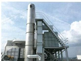
长度加高后的有机废气排气筒
