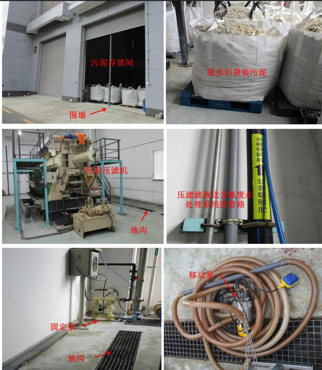
图 8-20 污泥存放间、压滤机、抽水泵
