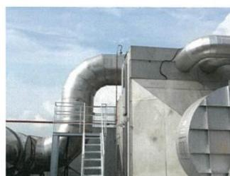
有机废气处理系统进气端设置的监测平台
