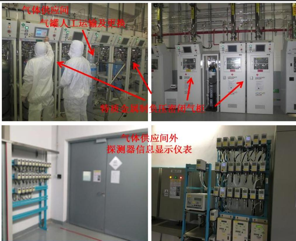
图 8-7 气体供应间、气体探测器显示仪表（部分）
